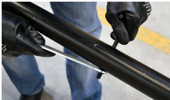
Fig.14 - Afrouxando parafusos e retirando as porcas
