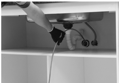
Figura 5 – Operación con cable espiral flexible de 8,0 mm (5/16")
