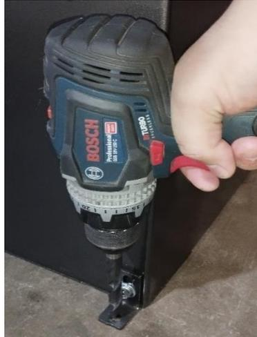
*Figura 8 - Fixação do parabolt*
