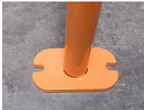
Figura 9 - Fixação dos pés dos varões
