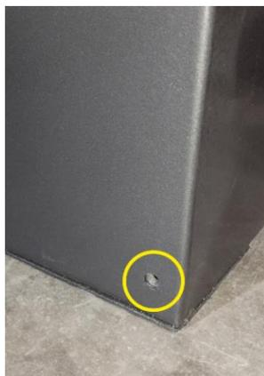
*Figura 7 – Ponto de fixação da cantoneira de chumbamento*
