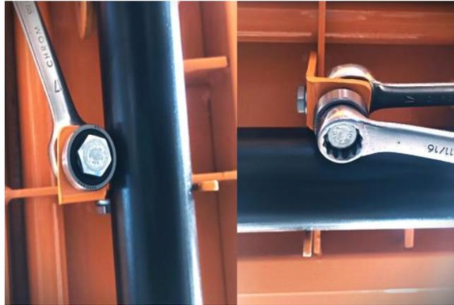
*Figura 20 - Posicionamento do rolamento*
