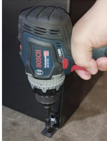
*Figura 8 - Fixação do parabolt*
