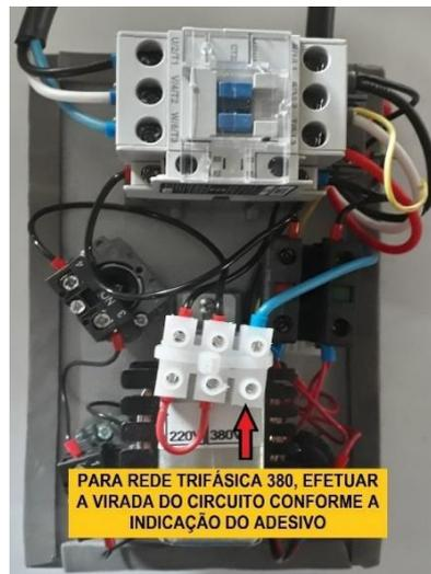
Figura 2 - Painel c/ transformador
